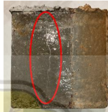
b. Pola Retak Sampel Beton 7
