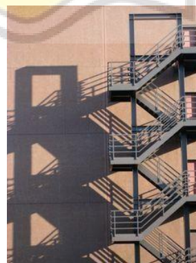
Gambar 3.50 Tangga darurat luar bangunan
