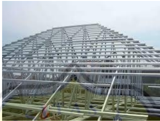
Gambar 3.24 Struktur atap baja ringan
