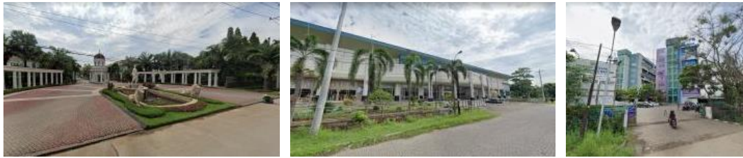
Gambar 3.24. Perumahan Royal Family (kiri), Bangunan Serbaguna (tengah) dan SMA Terang Bangsa (kanan).
