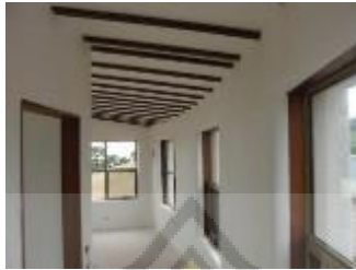
Gambar 53 Dinding dengan Material Hempcrete
