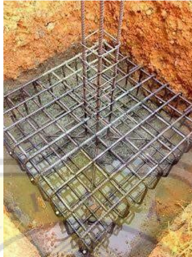
Gambar 65: Pondasi footplat Sumber: Data Pribadi, 2021
