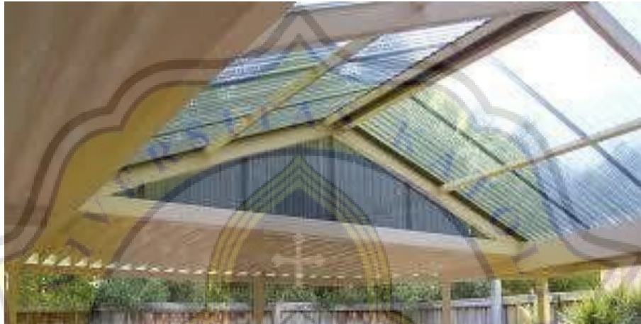
Gambar 68: Atap bangunan menggunakan bahan Fiber
