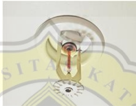
Gambar 72 sprinkler kebakaran
