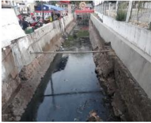
Gambar Kondisi utilitas saluran pembuangan
