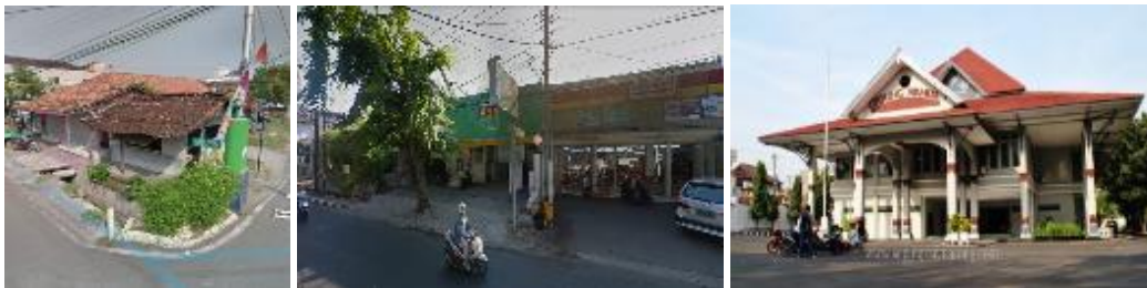
Gambar 39 Bangunan Sekitar Tapak
