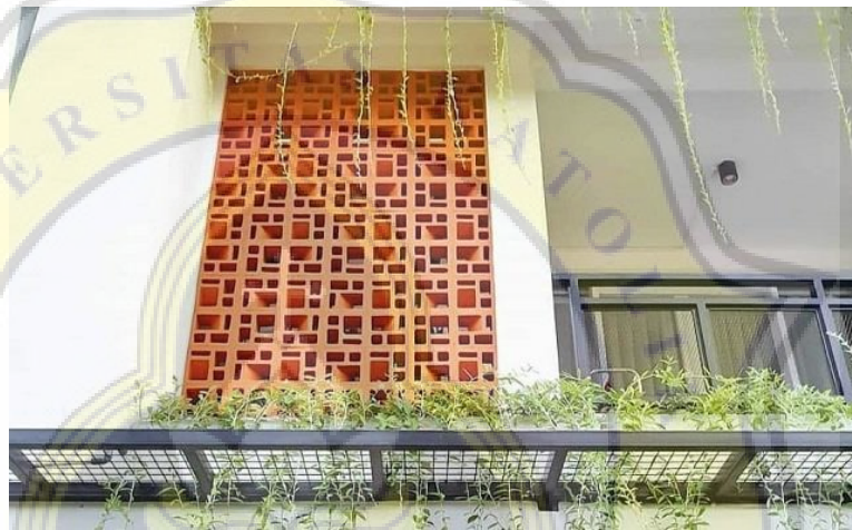
Gambar 6. 12 Penempatan Bata Roster (sumber: 99.co)
