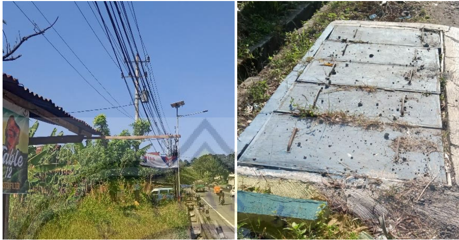
Gambar 3. 34 Utilitas Tapak (sumber: dokumentasi pribadi)
