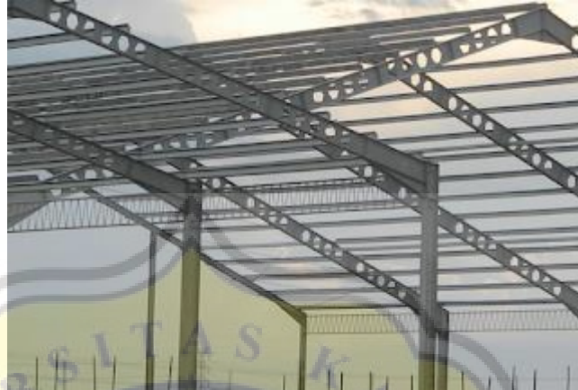
Gambar 3. 52 Rangka Atap Baja Konvensional (sumber: spesialiskonstruksi.com )
