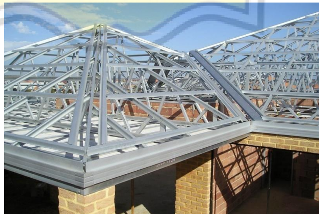
Gambar 3. 53 Rangka Atap Baja Ringan (sumber: dekoruma.com )
