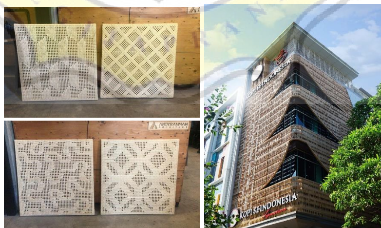
Gambar 130. Panel Rotan Sintetis & Penggunaan Façade Rotan Sintetis Pada Bangunan Kopi Se-Indonesia
