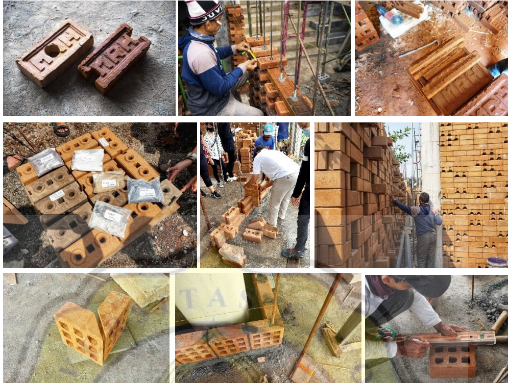
Gambar 122. Aplikasi Material Bata, Roster, dan Bata Interlock
