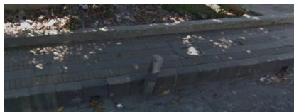
Gambar III. 21 Saluran Drainase Tertutup Sekitar Area Tapak
