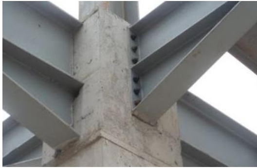
Gambar 41 Sambungan antara kolom beton dan balok besi IWF Sumber: google.com
