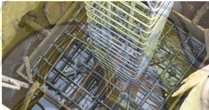
Gambar 40 Pondasi Foot Plat Sumber: google.com
