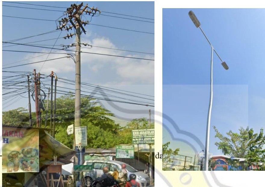
Gambar 4. 3 Tiang Listrik dan Lampu Penerangan Jalan
