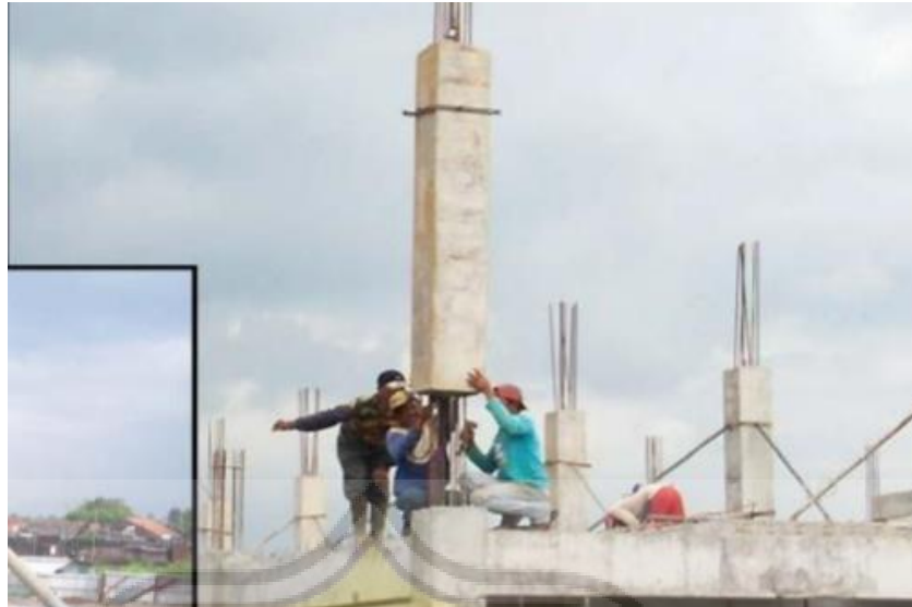
Gambar 40 Pemasangan kolom pracetak (sumber: Reyhan, 2017 dalam Abdurrahim, 2018)
