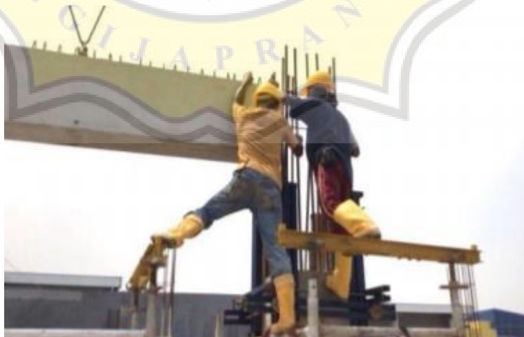
Gambar 42 Pemasangan balok pada kolom pracetak (sumber: Admilhusia, 2020)
