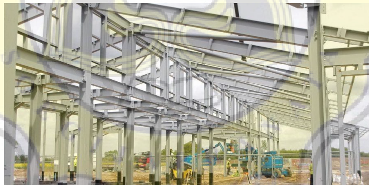
Gambar 32. Struktur Atap Baja WF
