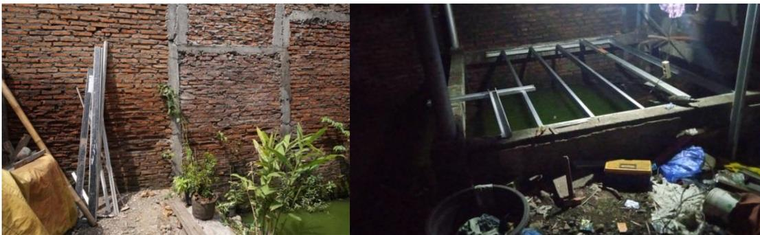
Gambar 8: Potongan baja ringan yang sudah disiapkan sebagai penguat penutup alas duduk (kiri) ; Pemasangan baja ringan pada kolong (kanan)
