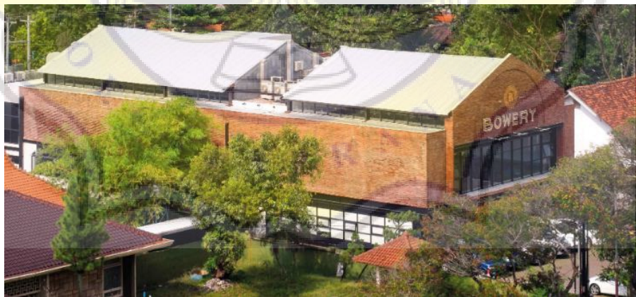
Gambar Lampiran 1.13. Restoran Bowery Tampak Luar
