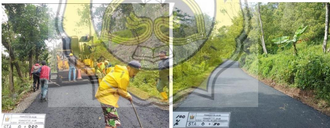
Gambar 5.13 Proses Pengerjaan Pengaspalan Jalan STA 0+000 dan Hasil Pekerjaan (Sumber: Dokumentasi proyek peningkatan jalan Bubak – Wiyoro Kabupaten Pekalongan, 2020)
