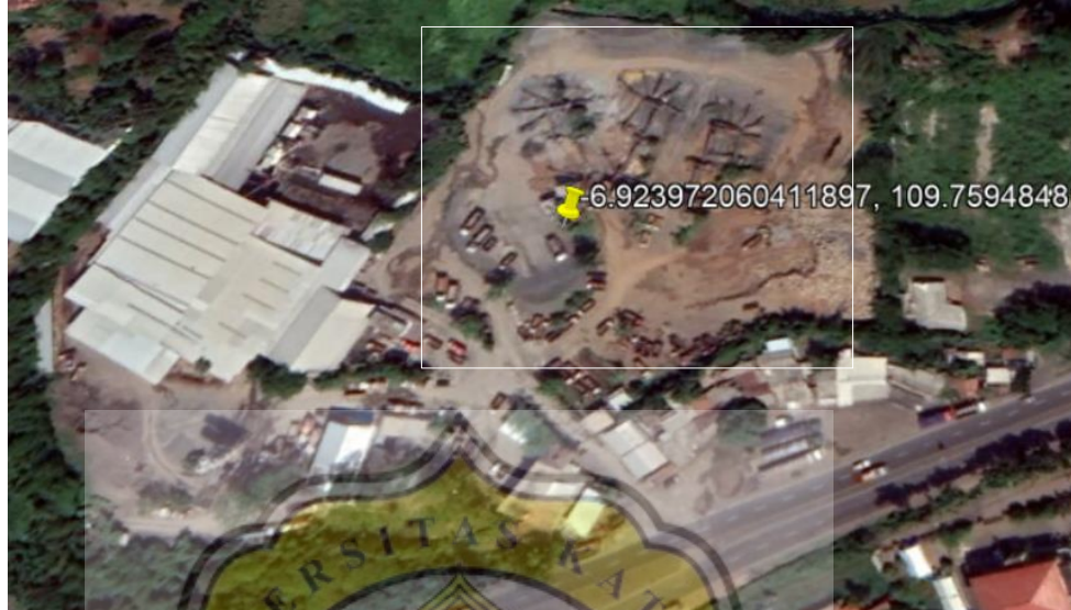
Gambar 4.3. Lokasi Kantor dan Batching Plant PT. Karya Barata Sakti (Sumber: https://earth.google.com/web/search/pt+karya+barata+sakti )
