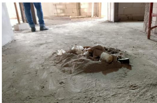
Gambar 4.6. Polusi yang Ada di Lokasi Proyek
