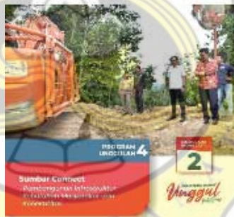
Gambar 4. 142 Pembangunan 13 waduk/embung untuk menjaga pasokan air bagi pertanian, masyarakat, listrik dan pariwisata Sumber: @sumbarunggul
