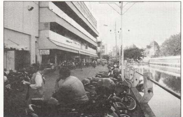
Lokasi lingk sekitar pasar Johar Sungai sebagai arah hadap bangunan
