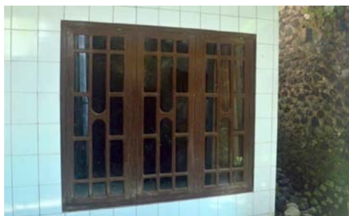
Gambar6:Jendela tanpa ventilasi (sumber: Dok.Peneliti, 2018)
