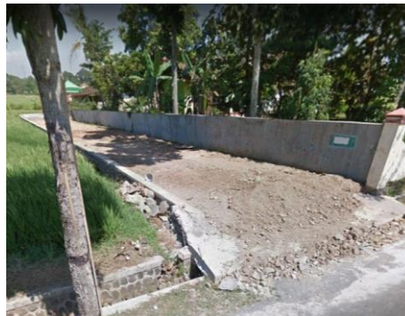
Gambar 18 : Kondisi Akses Sekitar
