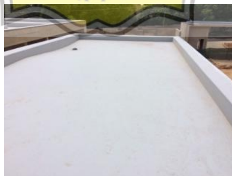
Gambar 7.7 Struktur Atap Dak Beton
