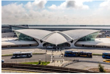
Gambar 7.3.3-3 Struktur Cangkang pada TWA Flight Center, New York
