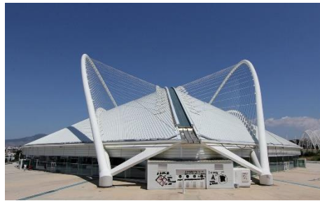
Gambar 7.3.3-7 Struktur Kabel pada OAKA Olympic Velodrome
