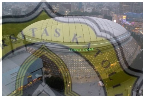
Gambar 7.3.3-8 Struktur Pneumatik pada Tokyo Dome
