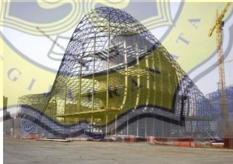
Gambar 7.3.3-5 Struktur Rangka Ruang pada Heydar Aliyev Cultural Centre
