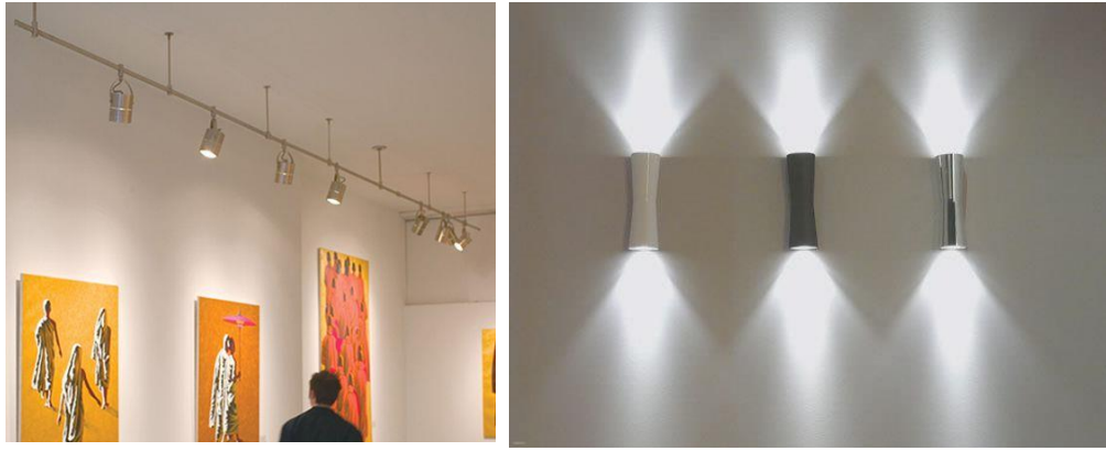
Gambar 7.4.5-2 Contoh Aplikasi Teknik Tracklight & Wall Washer
