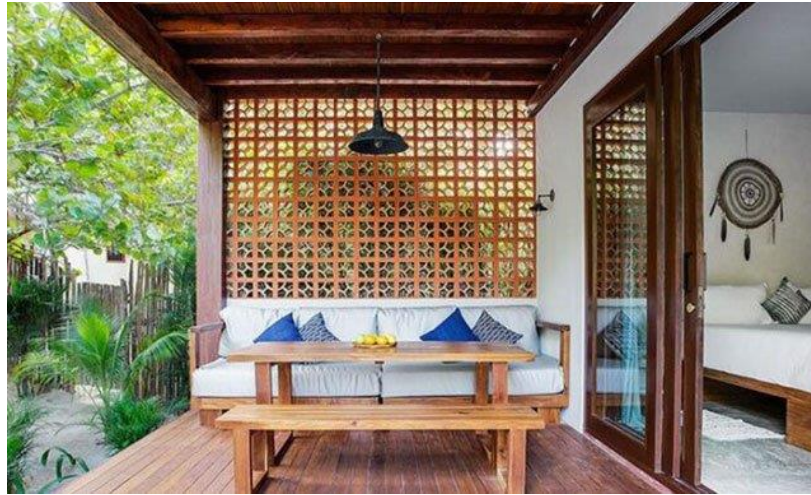
Gambar 7.3.2-4 Penerapan Roster sebagai Dinding Bangunan
