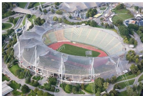
Gambar 7.3.3-6 Struktur Membran pada Olympia Stadium, Munchen
