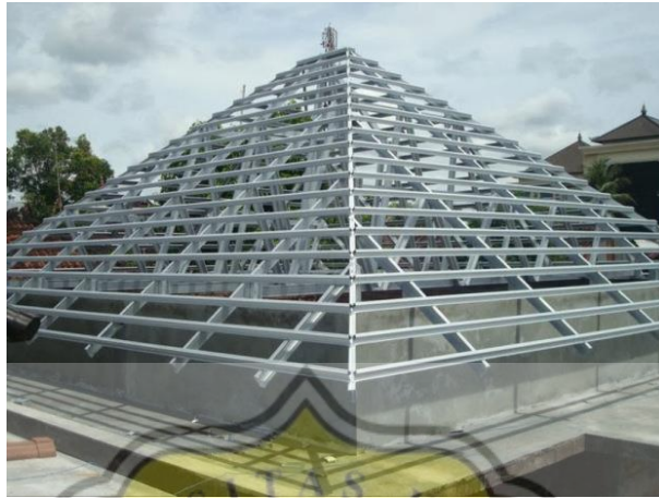
Gambar 7. 8 Kontruksi atap baja ringan
