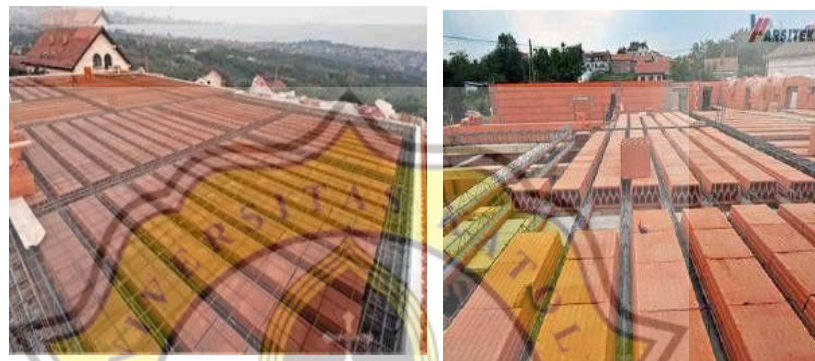
Gambar 79 – Struktur Atap Dak Beton
