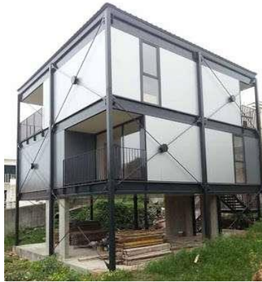
Gambar 7. 3 Struktur Baja Baut Sumber : www.arsitur.com
