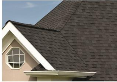
Gambar 60. Penutup Atap Bitumen
