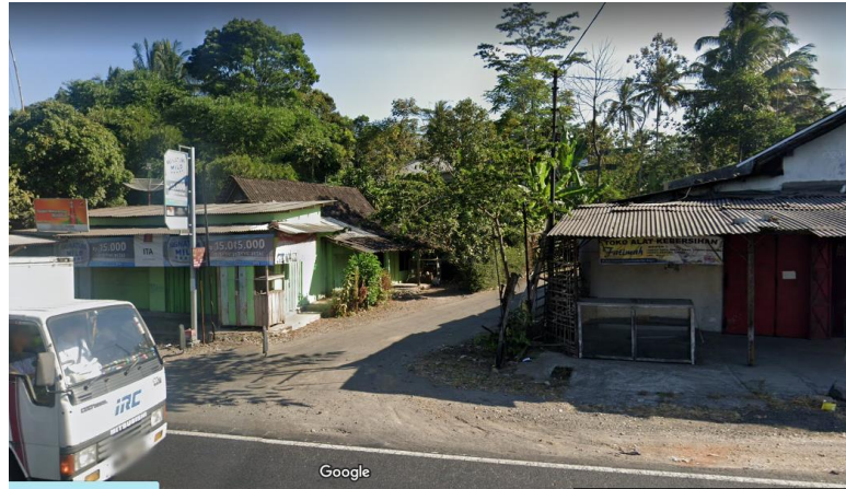
Gambar 39: Keadaan utilitas listrik di jalan raya terdekat
