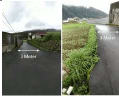
Gambar 53. Perempatan Jalan Perkampungan
