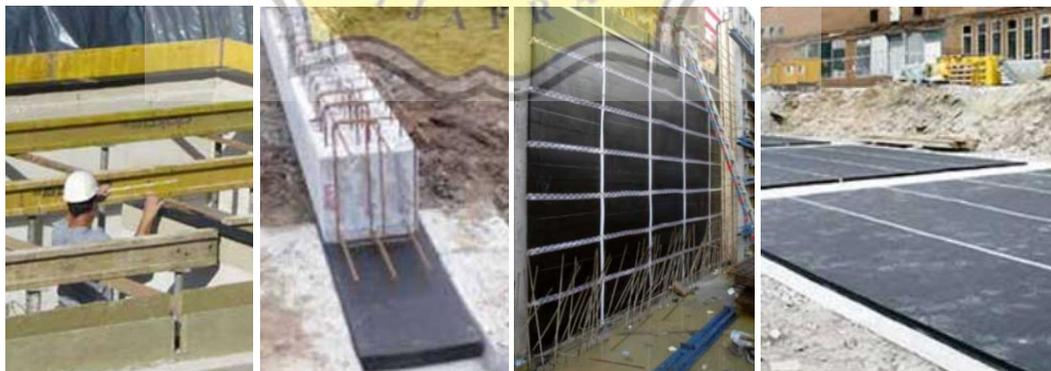
Gambar 30 Penerapan peredam getaran secara titik, garis, dan keseluruhan pada bidang
