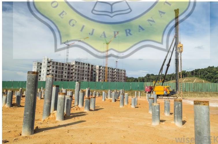
Gambar 36 Pile beton yang sudah dipasang
