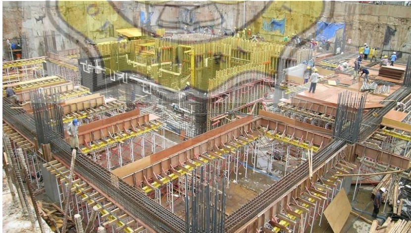
Gambar 39 Kolom Beton Bertulang
