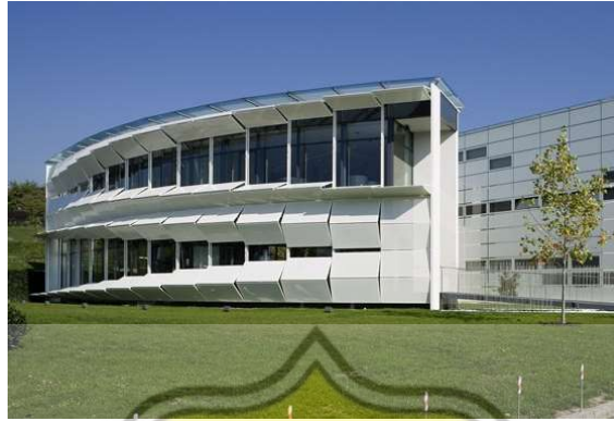
Gambar 85 Foto bangunan Kiefer Technic Showroom Sumber: architonic.com
