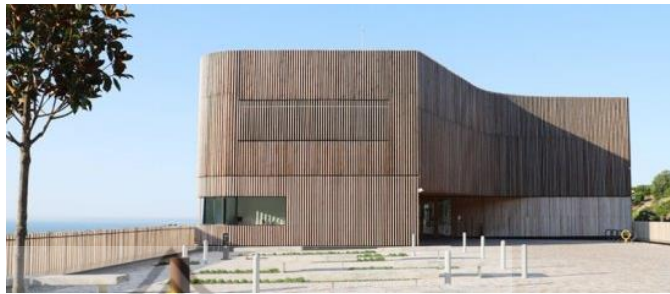
Gambar 57 Material Kayu Sebagai Pelapis dinding
