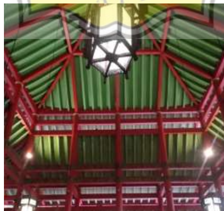
Gambar 46 Struktur Kuda Kuda Beton
