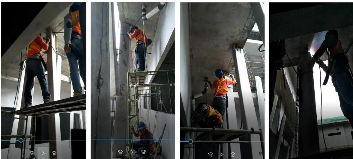
Setelah memposisikan precast panel pada tempatnya, dilakukan penguncian sementara panel supaya tetap dalam kedudukannya terutama pada konstruksi pijakan panel.
