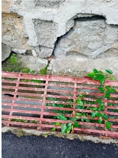
Gambar 19. Dokumentasi kerusakan di Sport Hall.
