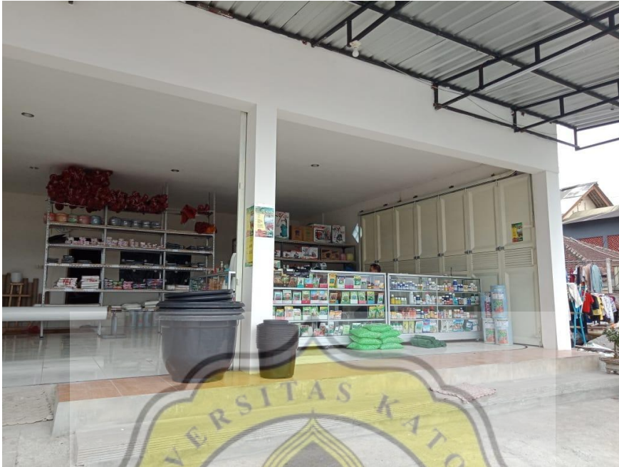
Gambar 5.1 Kondisi Toko Tampak Depan
