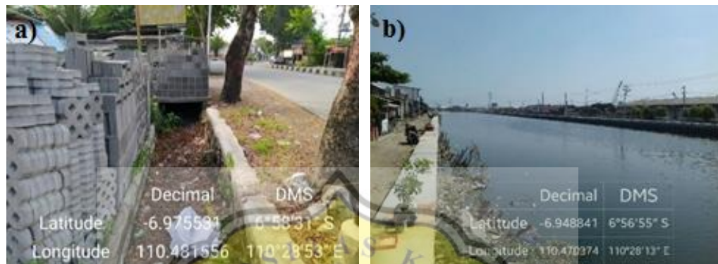
Gambar 4.2 Kondisi Eksisting Sungai Sringin
