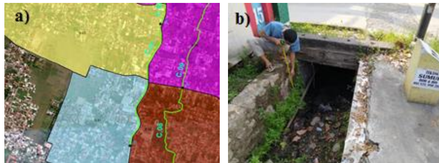
Gambar 4.11 Kondisi Eeksisting Conduit Sungai 01 Sringin
