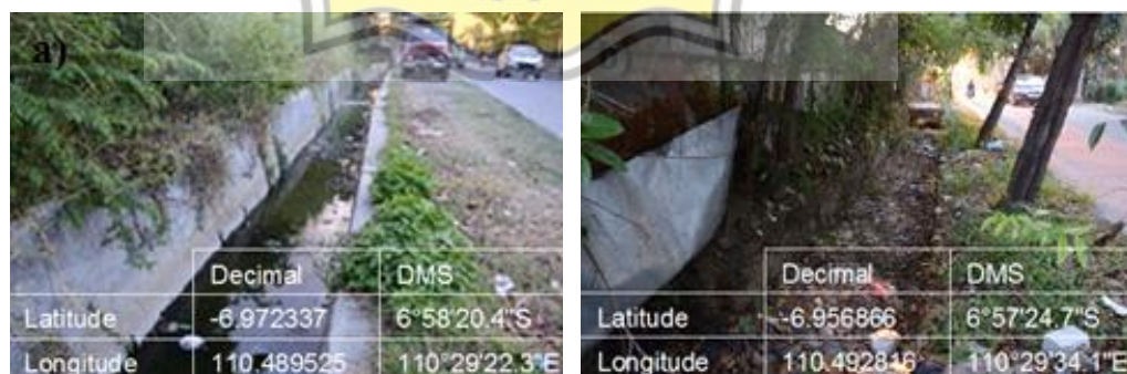
Gambar 4.3 Kondisi Eksisting Sungai Sringin
