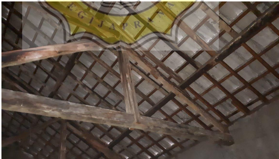
Gambar 5. 37 : Kuda-kuda atap rumah A.T.Ng.Moeljo [Sumber : Dokumentasi Pribadi, 2020]
