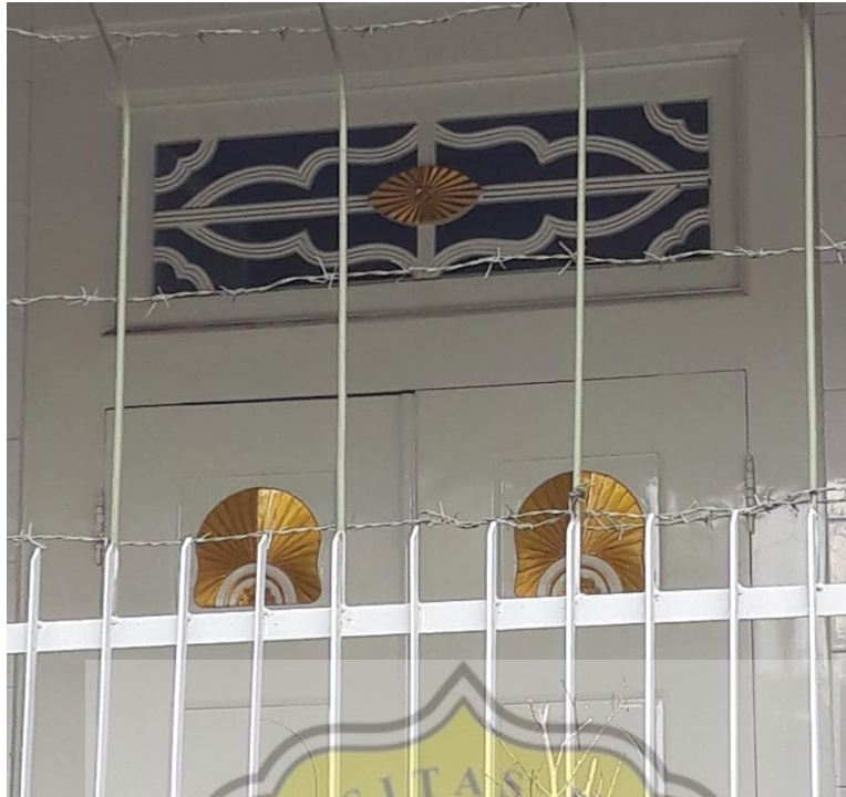
Gambar 5. 60 : Pintu utama rumah putih di Kampung Kulitan [Sumber : Dokumentasi Pribadi, 2020]
