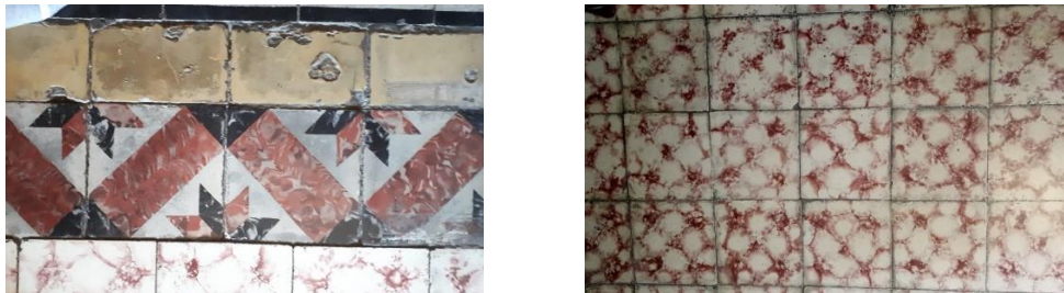
Gambar 5. 19 : Tegel lantai rumah A.T.Ng.Moeljo masih asli ukuran 20x20 [Sumber : Dokumentasi Pribadi, 2020]
