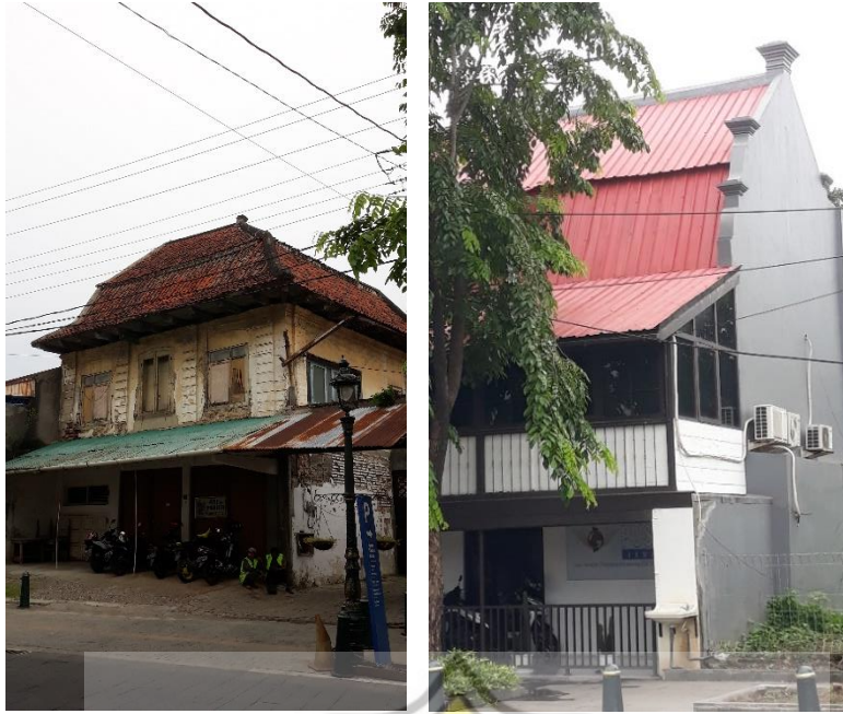
Gambar 5. 32 : Contoh atap Dormer's in manshard roof di Kota Lama Semarang (Sumber : Koleksi foto pribadi Okt 2020)
