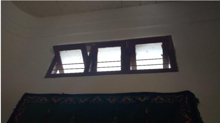
Gambar 4. 11 : Ventilasi pada ruang tengah menggunakan 3 jendela rumah A.T.Ng.Moeljo [Sumber : Dokumentasi Pribadi, 2020]
