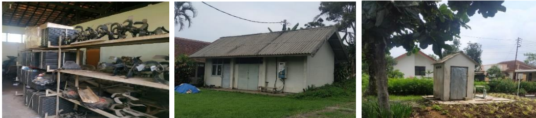
Gambar 20 Sarana Penunjang dari pojok atas kiri ruang peralatan pertanian, ruang instalasi genset dan listrik
