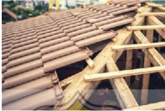
Gambar 60. Konstruksi atap kayu Sumber : Tukang.co
