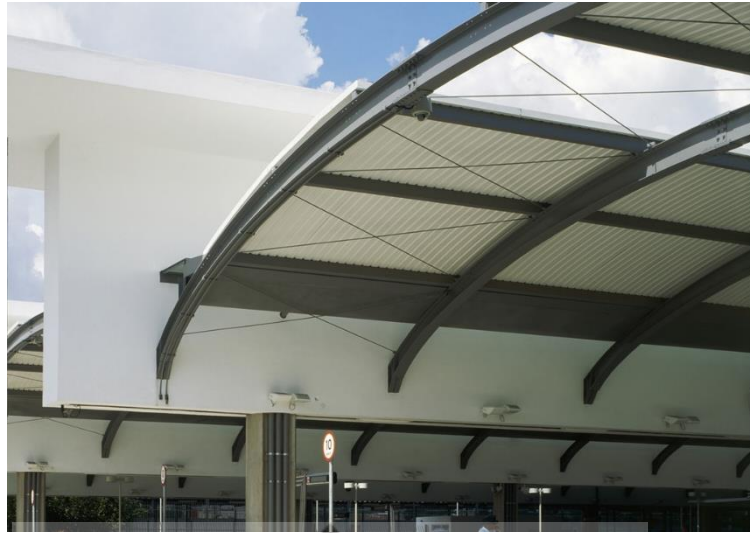
Gambar 7. 2 Contoh penggunaan baja IWF sebagai struktur atap
