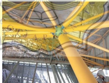
Gambar 7.8 : Sistem Sambungan Spaceframe
