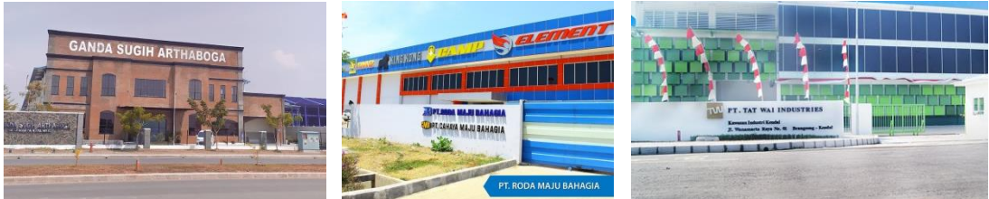
Gambar 16. Bangunan Industri Sekitar Tapak Sumber : Data Pribadi
