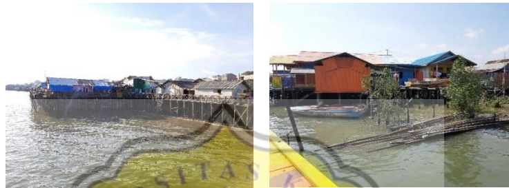
Gambar 65. Bangunan rumah masyarakat di sekitar tapak, pesisir Kota Balikpapan (kiri) dan pesisir Kota Penajam (kanan) (sumber: dokumentasi pribadi)
